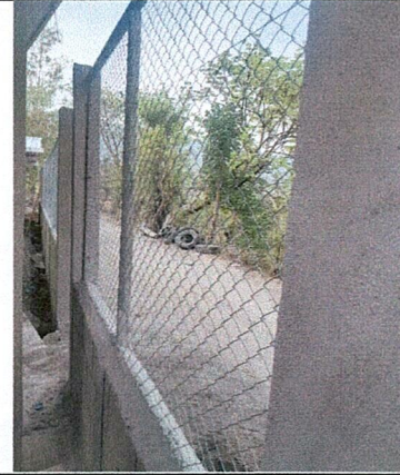
Foto 2: OTRA VISTA DE MEJORAMIENTO MURO PERIMETRAL.
