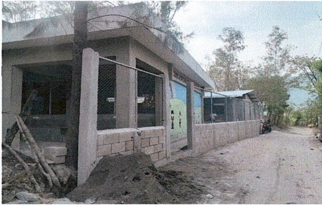
Foto 1: MEJORAMIENTO MURO PERIMETRAL.
